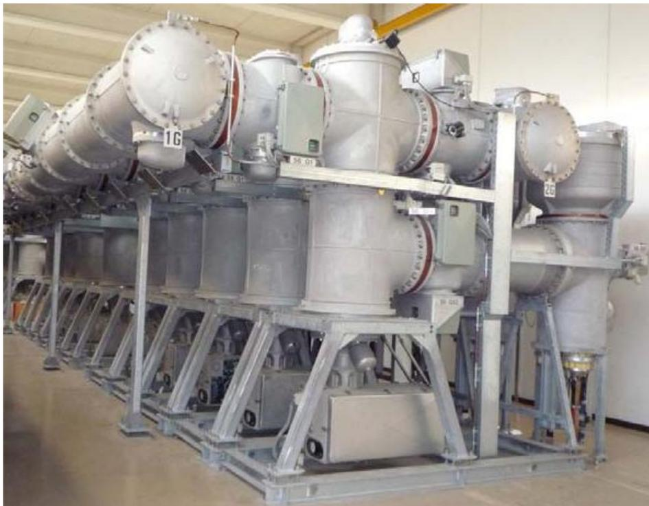
*Equipements HT du poste de Galicien avec isolation SF<sub>6</sub> de type ELK de ABB*
