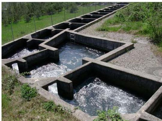
*Echelle à poissons en béton
