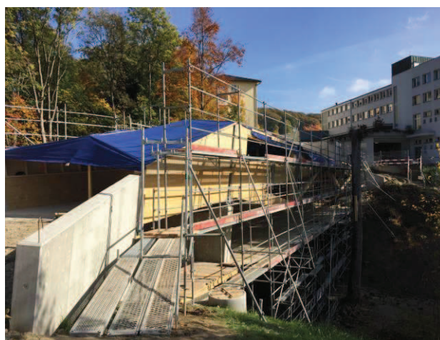
La passerelle et ses chemins d'accès sont destinés à la fois aux piétons et aux cyclistes.
