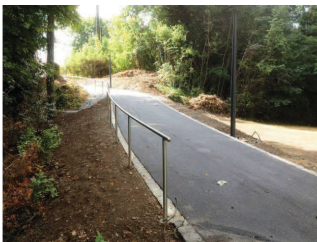
La création de cette rampe qui remplace les escaliers permet d'offrir une nouvelle liaison pour les vélos et de faciliter le passage des piétons.
