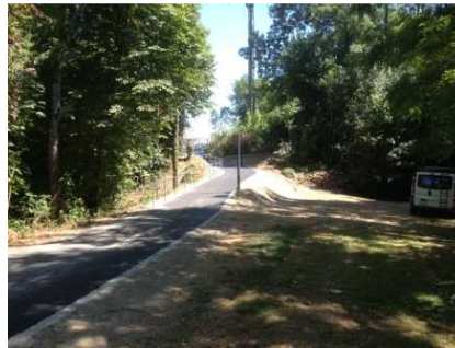
Escaliers de la Vuachère après travaux
