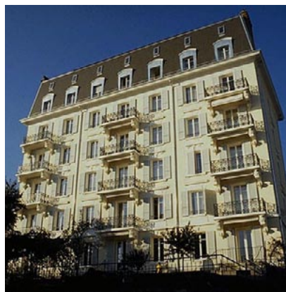
Façade sud du bâtiment
