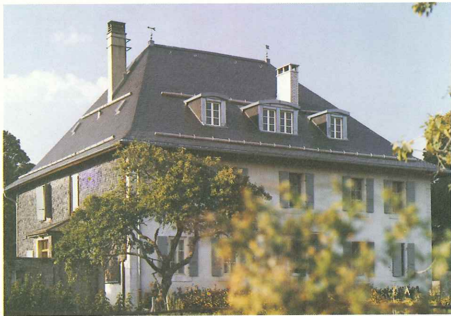
14. Ferme à Longirod. Vue après restauration de la toiture (in « Toitures », Chantiers 9/1979).
