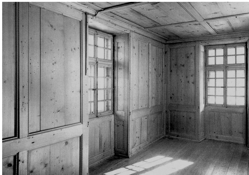
Cure de Rougemont, Le lambrisage traditionnel contribue au confort thermique intérieur
