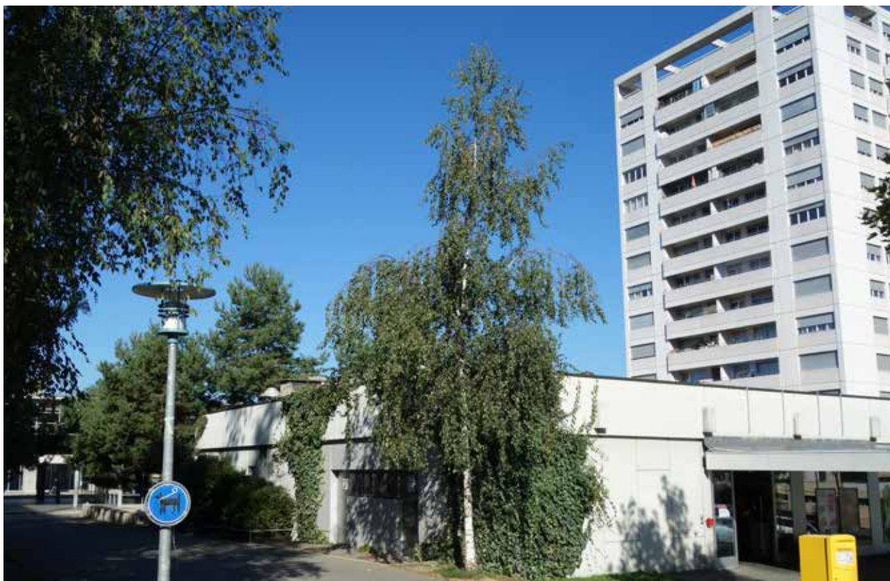
Immeuble et centre commercial au chemin d'Entre-Bois.
