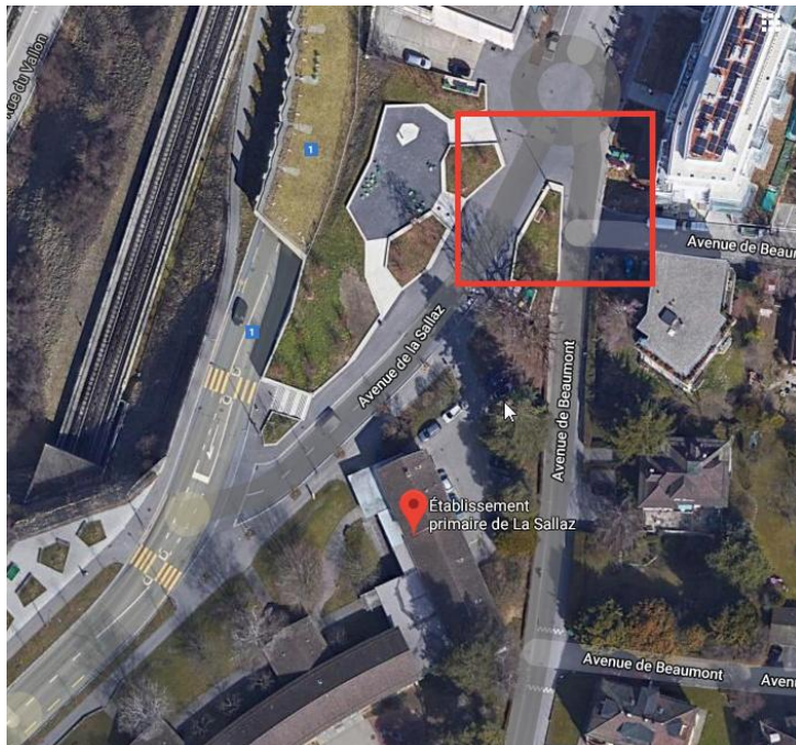
Photo 4 Av. de Beaumont , proximité de l'école de la Sallaz .....Disparition du trottoir, axe dangereux pour les piétons qui traversent
