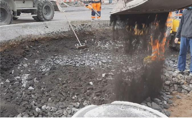
Mise en place des pierres 80/150 sur une épaisseur de 20cm et répartition homogène du TP70 (= 250 litres TP70 /m3 pierres)
