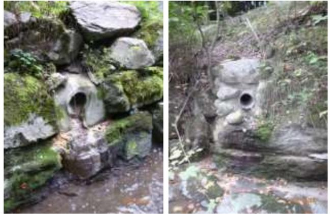
Figure 6 : Exutoires, rejets de conduites EC lausannoises dans un cours d'eau
