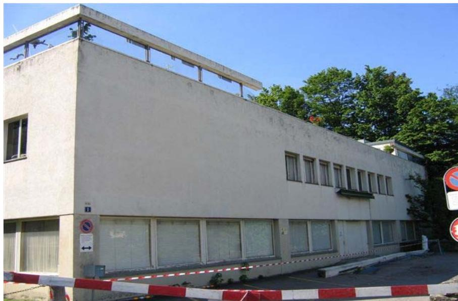
Une intervention d'urgence a été nécessaire afin de sécuriser le périmètre, car un diagnostic rapide a permis de conclure à la corrosion de tous les supports métalliques du parapet en béton. Ce dernier doit donc être enlevé et remplacé par une nouvelle barrière.
