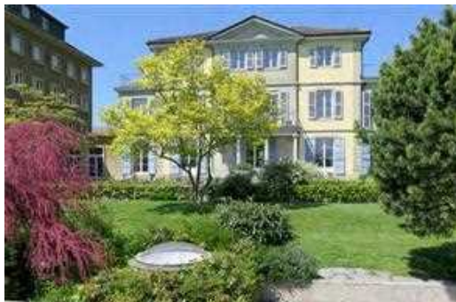
5. Façade sud de la maison de maître et aménagements extérieurs
