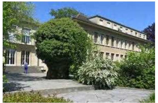
10. Façades sud de la chapelle et du collège
