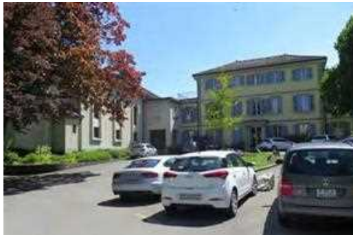
3. Cour d'entrée et façade nord de la maison de maître ainsi que façade latérale de la chapelle
