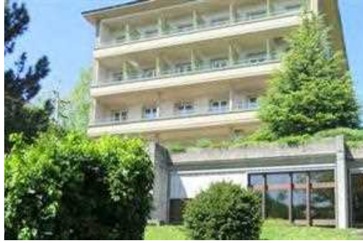
7. Façade sud de l'internat et façade du gymnase au premier plan
