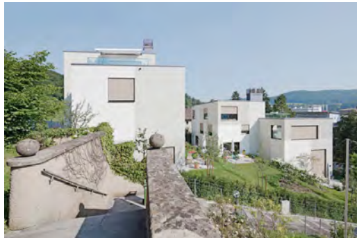
Implantation de nouvelles constructions dans la pente, Gigon/Guyer, Housing Complex Villa Pax, Baden
