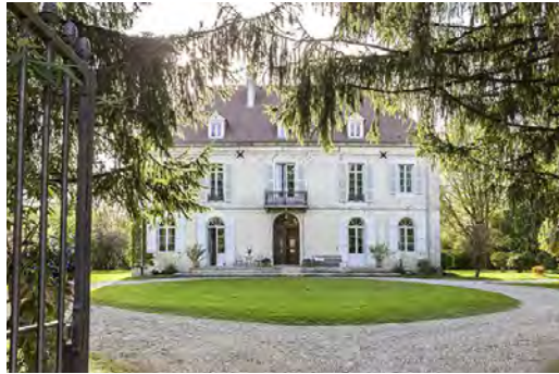
Cour en accueil de la maison de maître
