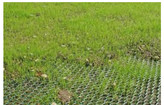
Gazon stabilisé alvéolaire pour permettre l'accès aux pompiers dans le parc tout en garantissant un aspect vert
