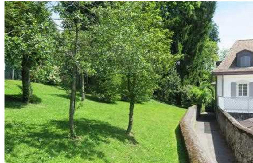
Montolivet, murs de soutènement en limite de propriété et talus engazonnés
