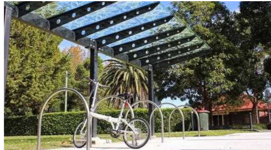
Des abris discrets aux couleurs sobres s'intégrant facilement dans leur environnement
