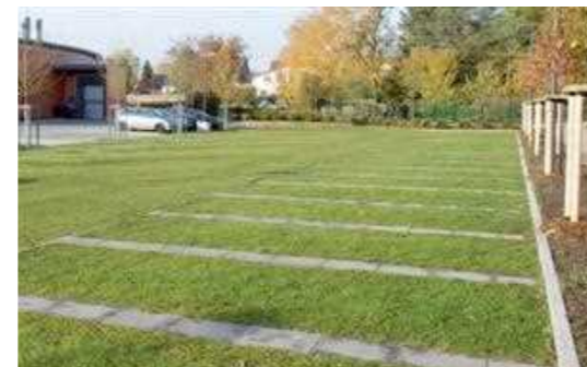
Places de stationnement en gazon alvéolaire (grille béton-gazon)
