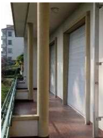
Fig. 74. Façade sud, rez-de-chaussée.
