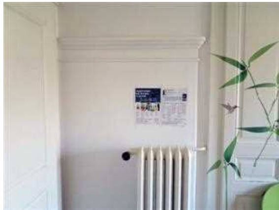
Fig. 38. 2 e étage, nord-ouest, poêle.
