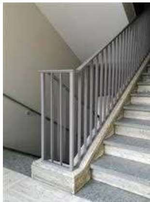
Fig. 60. Escalier, 1 er étage.
