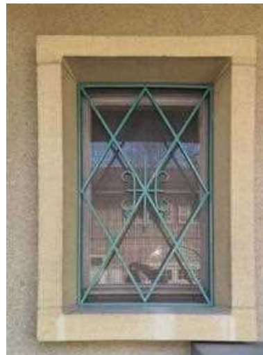
Fig. 73. Façade nord, rez-de-chaussée.
