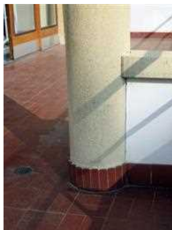
Fig. 75. Façade sud, rez-de-chaussée.
