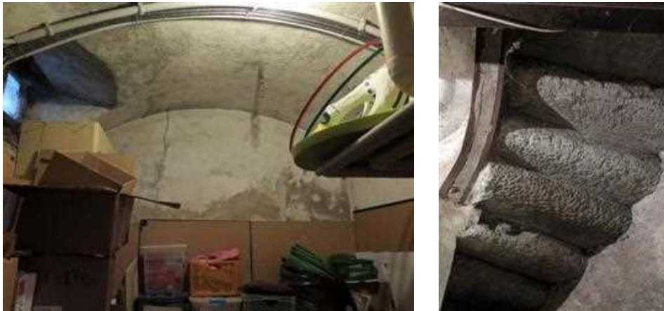
Fig. 22. Cave et escalier de la cave.
