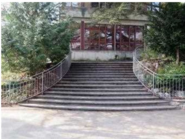
Fig. 122. Escalier à l'angle sud-est du gymnase.
