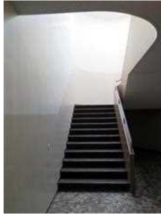
Fig. 115. Escalier menant du rez-de-chaussée à l'étage.
