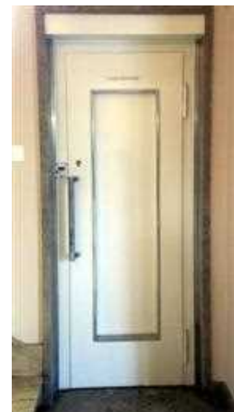
Fig. 83. Porte d'ascenseur au rez-de-chaussée.
