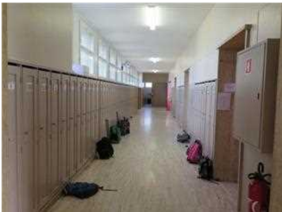
Fig. 59. Corridor, 1 er étage.
