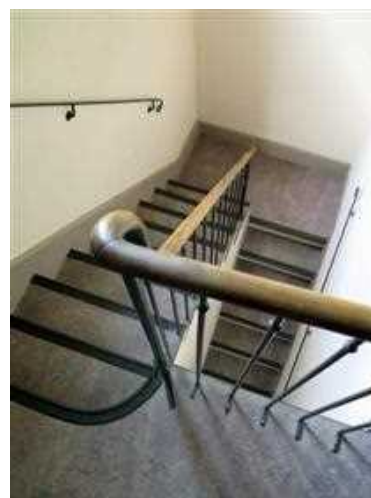
Fig.41. 2 e étage, escalier de service.
