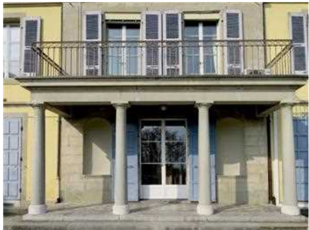
Fig. 16. Façade sud, portique.
