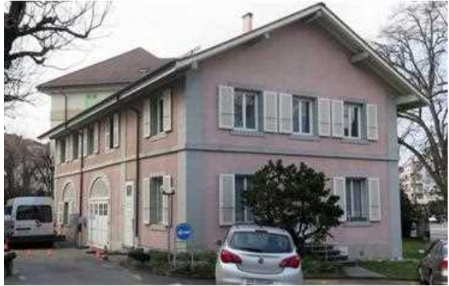
Fig. 52. Dépendance, façade est.
