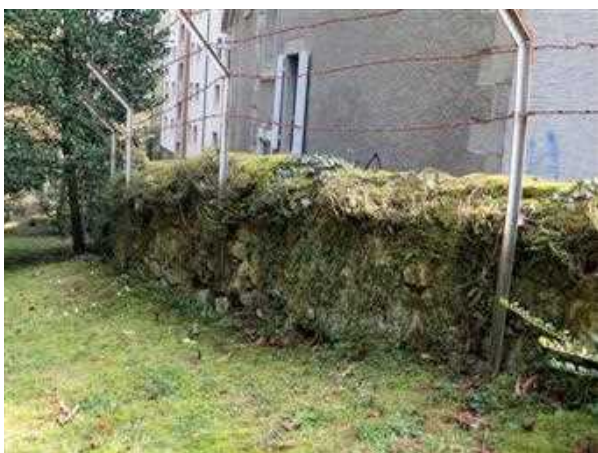
Fig. 129. Mur de clôture au sud du jardin.
