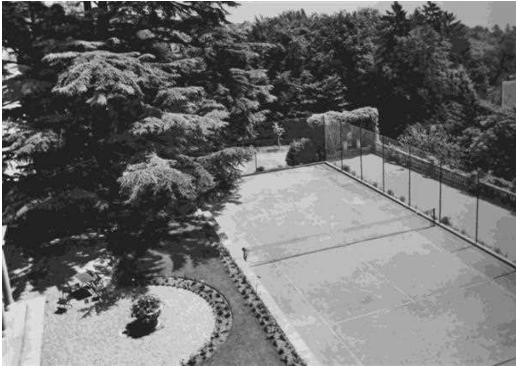
Fig. 121. Le court de tennis sur la terrasse supérieure, entre 1951 et 1973 (Archives de l'Institut catholique Montolivet). Devant la maison de maître, la vasque décorative est déjà présente.
