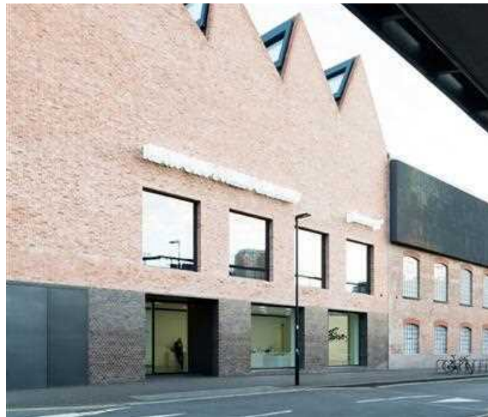
la façade guide la rue et a un lien fort avec le paysage urbain
