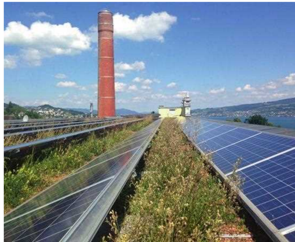
des toits verts extensifs inaccessibles recouverts de panneaux photovoltaïques cachés
