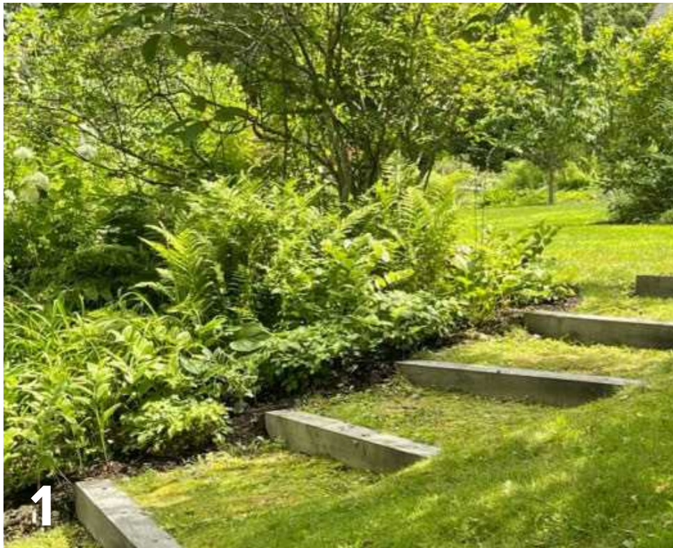
1 l'eau de pluie descendant du talus est ralentie par les marches
