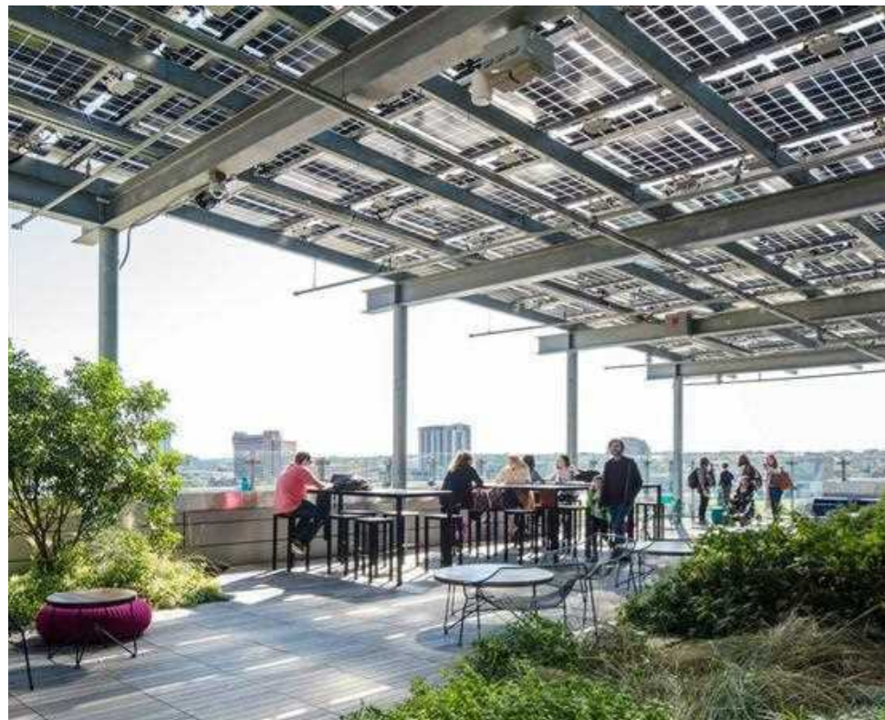
les terrasses partagées couvertes de panneaux photovoltaïques, par exemple sous forme d'auvent
