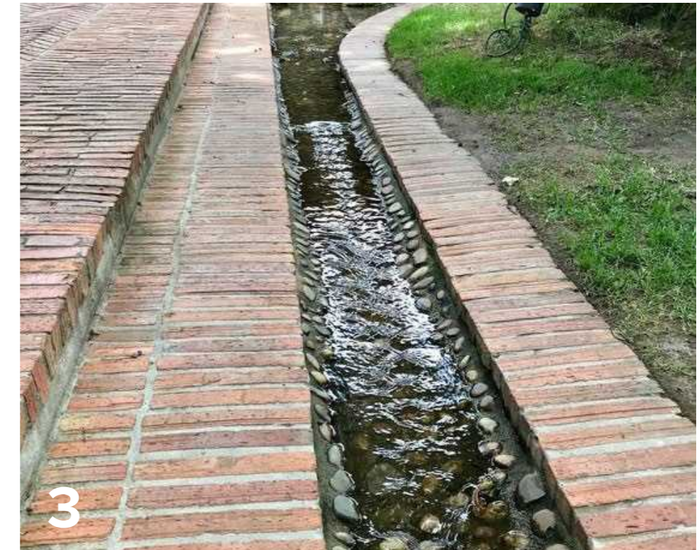
3 un collecteur d'eau de pluie au début de la rue du Grand-Pré rend visible le nouveau système d'évacuation des eaux de pluie
