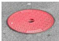
Sur les places de la Navigation et de Bellerive, les points de raccordement sont signalés par des regards de couleur rouge. Aucun raccordement ou déversement d'eaux, résidus ou déchets n'est autorisé dans les autres regards ou les grilles d'évacuation des eaux de surface.
