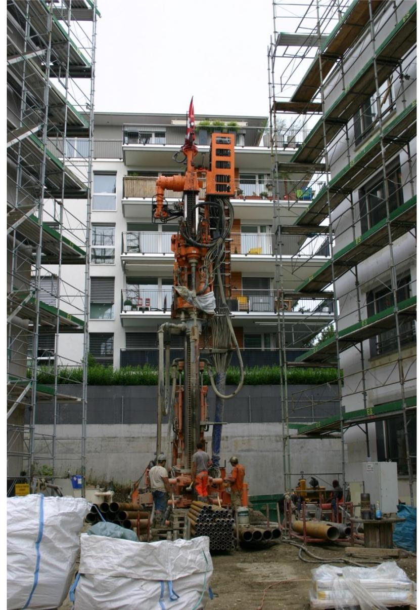
Le projet Képi a pour objectif de vérifier les conditions géologiques aux Plaines-du-Loup en réalisant un forage de reconnaissance dans la future zone d'implantation du champ de sondes (début du forage fin octobre 2014)
