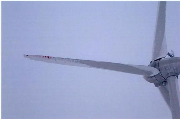
Ici le givrage d'une enercos à St-Brais : [http://www.meteotest.ch/uploads/RTEmagicP\\_2010\\_ice\\_stbrais\\_la\\_02.JPG](http://www.meteotest.ch/uploads/RTEmagicP_2010_ice_stbrais_la_02.JPG)
