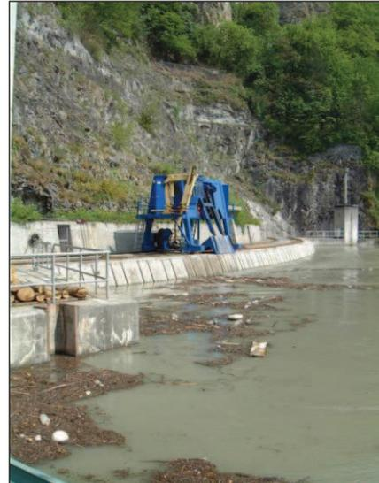
Les deux dégrilleurs actifs à la prise d'eau du barrage ont été mis en service respectivement en 1956 et 1976.
