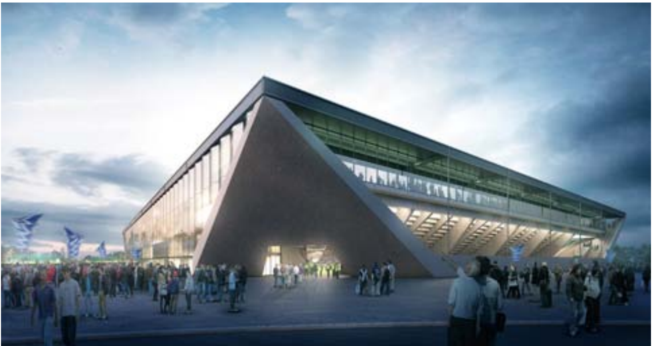
Vue du stade depuis l'angle sud-ouest
