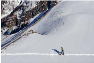
A l'extérieur du barrage – Grande Dixence
