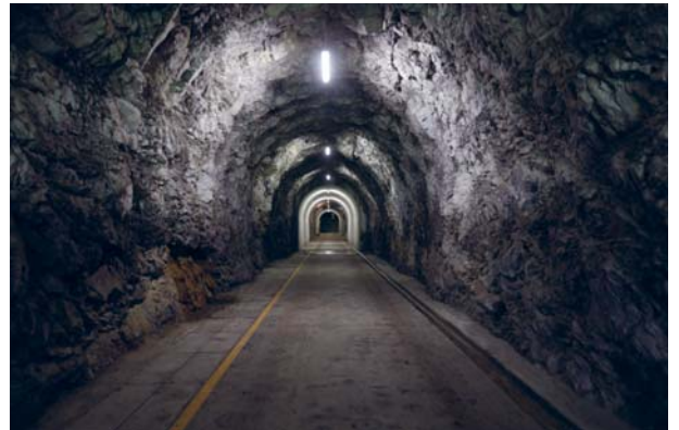
Dans la montagne – Centrale électrique de Lavey
