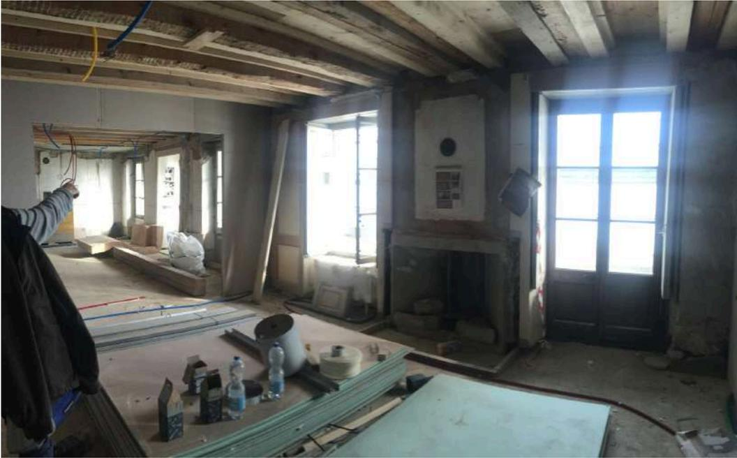
Fig. 13 : La Maison en chantier. Ouverture des cloisons en rez-de-chaussée - Source OUVDD, 2017
