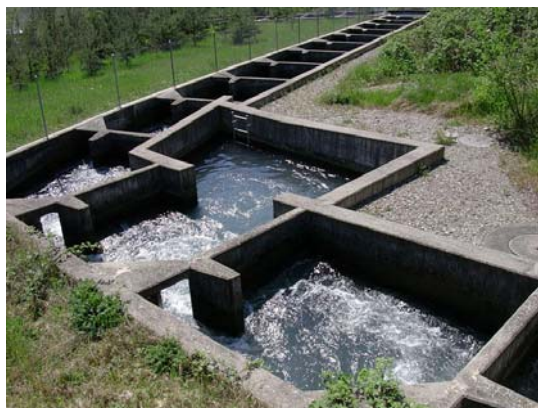
Echelle à poissons en béton au barrage de Verbois près de Genève (SIG)
