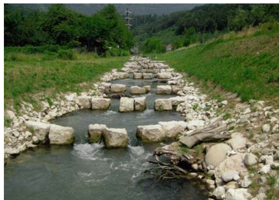
Passe à poissons « rivière artificielle » au barrage de Winznau près d'Olten (Alpiq)
