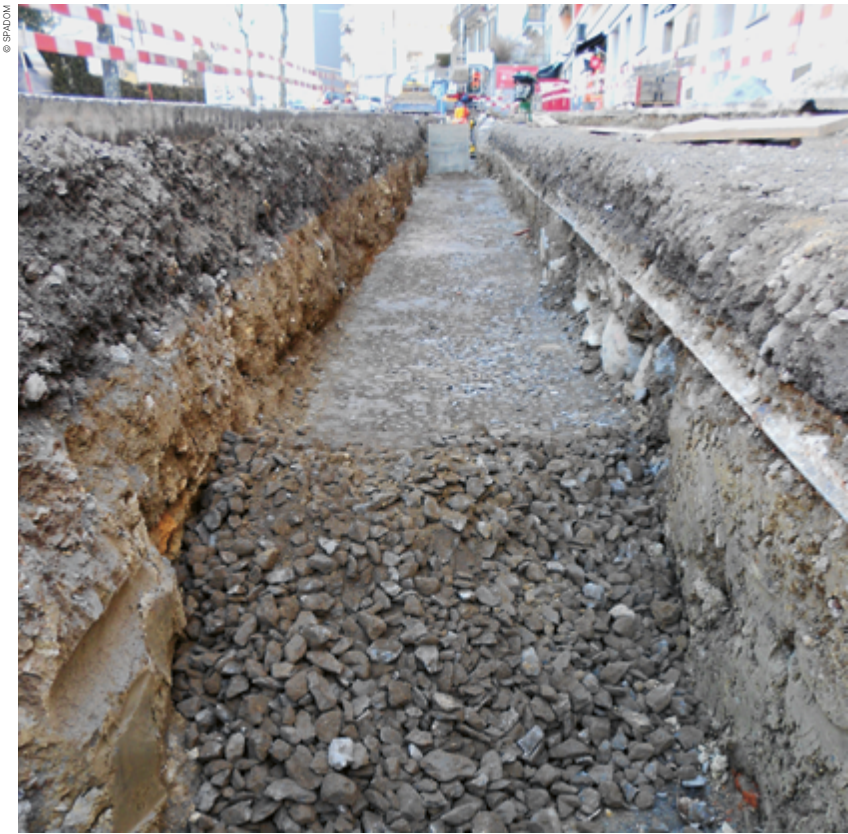
Mélange terre-pierre mis en place.
