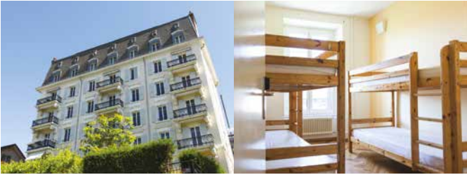
L’Étape, des logements d’urgence pour l’hiver 2018-2019 en remplacement de l’abri PC de la Vallée de la Jeunesse © Marino Trotta / VDL
