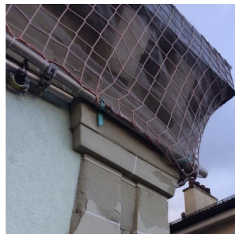
Filet de protection installé sur la façade sud
