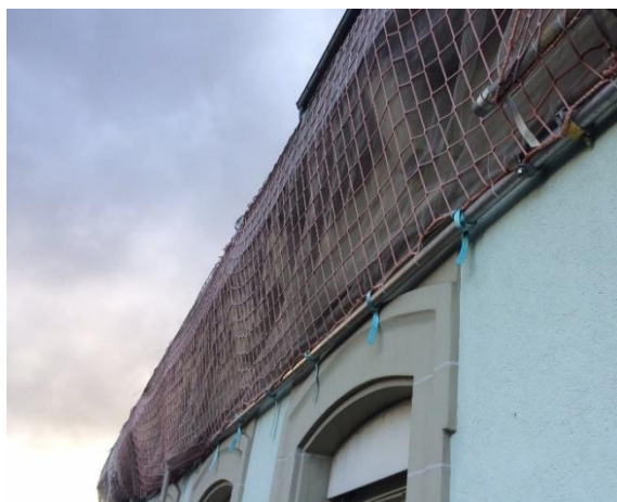
Filet de protection installé sur la façade sud
