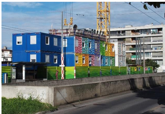
Figure 10 : Habillage des containers de chantier du Tunnel du LEB au Parc de la Brouette
