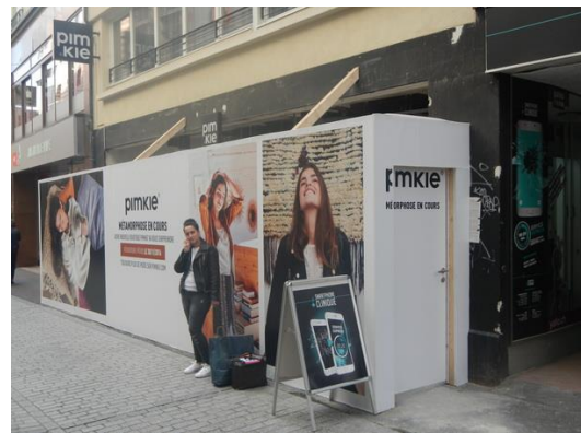
Figure 9 : Chantier rue Saint-Laurent
