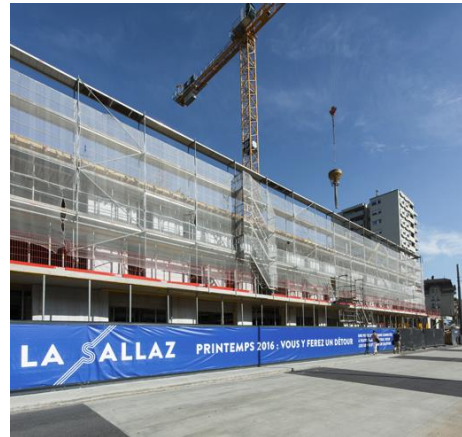
Figure 8 : Chantier place de la Sallaz
