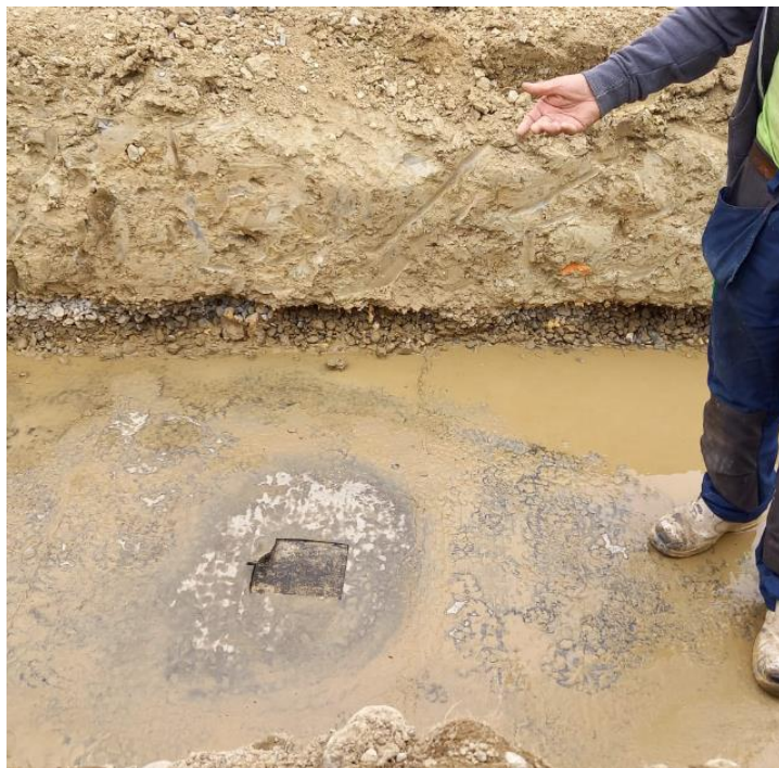
Sondage dans l'étanchéité de toiture
