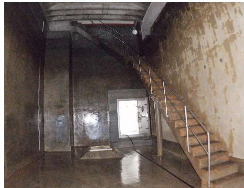
Escalier existant et conduit du trop-plein
