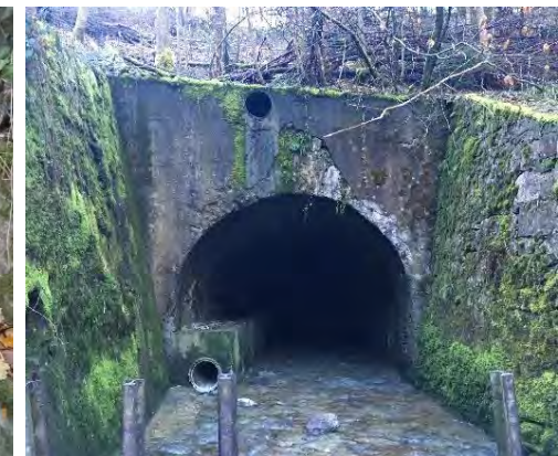
Mise sous terre
