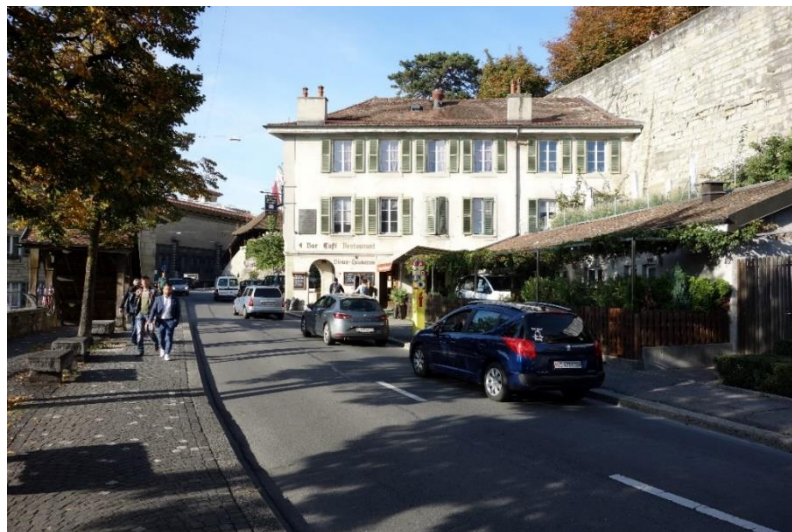
La rue Pierre-Viret, axe historique faisant partie de la ceinture Pichard. Son aménagement actuel revêt un fort caractère routier qui n'est pas à la hauteur des potentiels du cœur médiéval de la ville. Source : Ville de Lausanne
