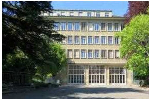
11. Façade sud du collège
