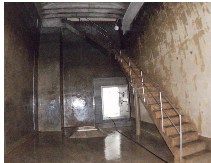
Escalier existant et conduit du trop-plein
