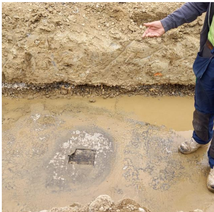
Sondage dans l'étanchéité de toiture
