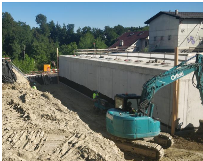
Construction de la nouvelle cuve
