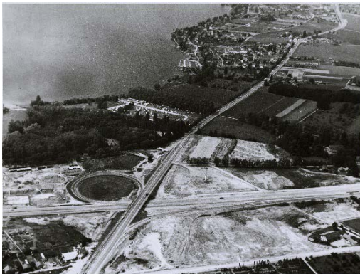
A.Würgler, Construction du giratoire de la Maladière, photographie, 1962. MHL
