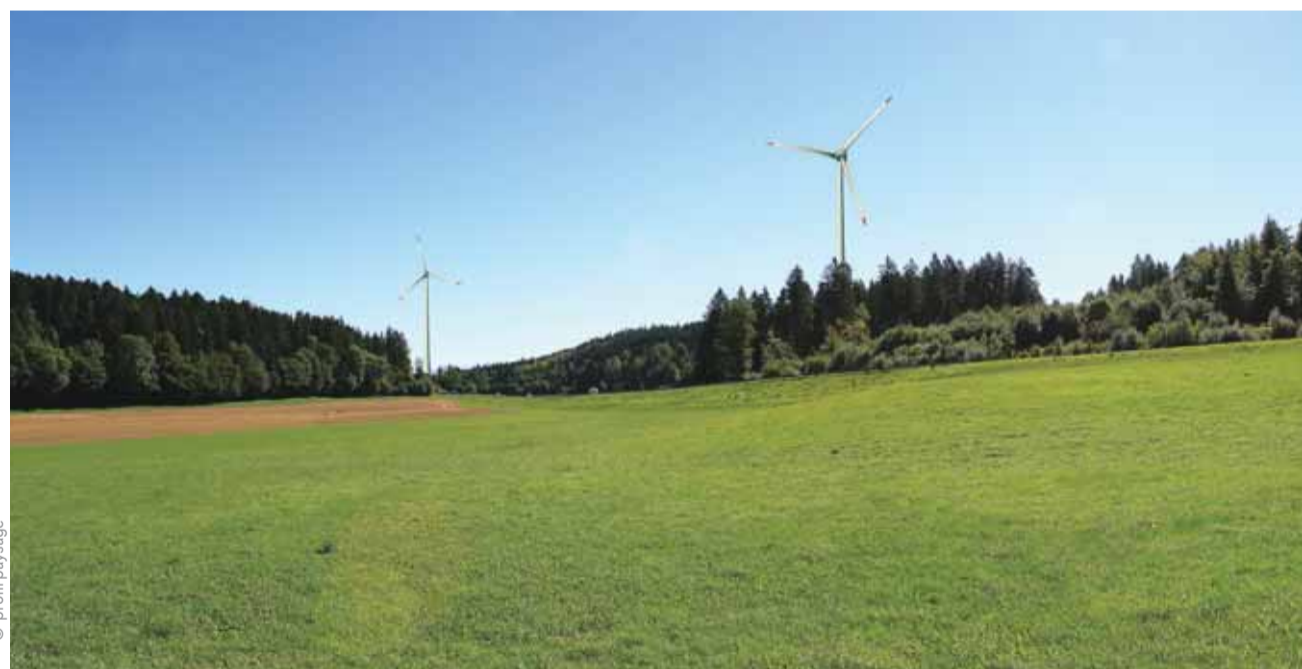
Huit éoliennes dans les bois du Jorat viendront d'ici 2026 renforcer la sécurité de l'approvisionnement électrique en hiver.
