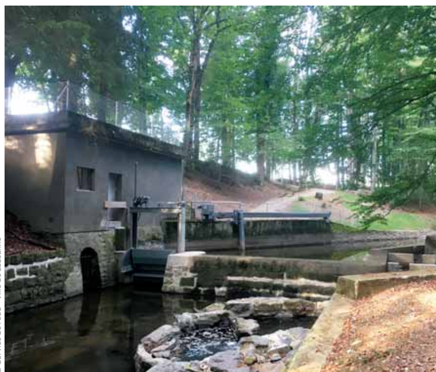
Le barrage sur le Grenet.
