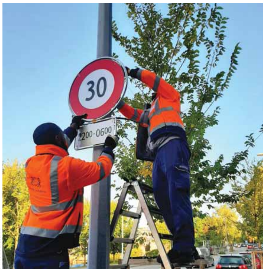
Tous les panneaux sont désormais installés.
