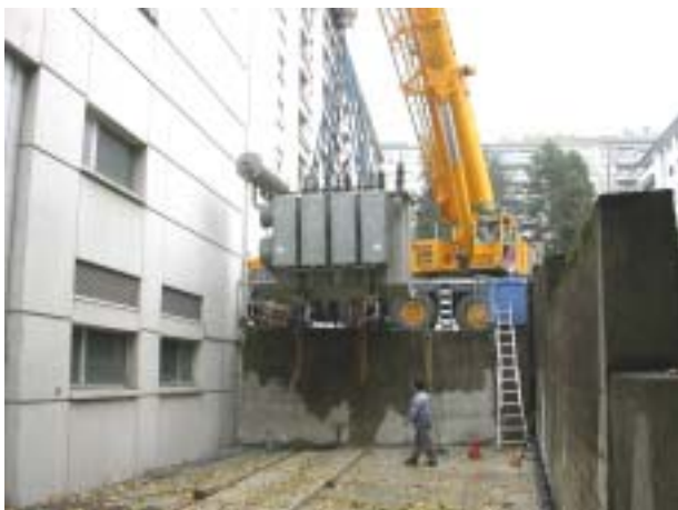
Boisly : mise en place du 3 ème transformateur
