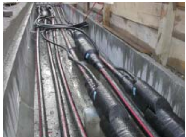
Jonction des câbles 125 kV à Valmont
