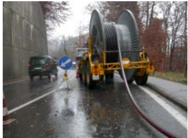
Tirage des câbles 125 kV à Rovéréaz
