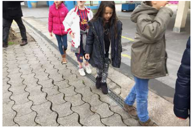
Les grilles d'évacuation fonctionnent aussi comme limites continues pour séparer des espaces.
