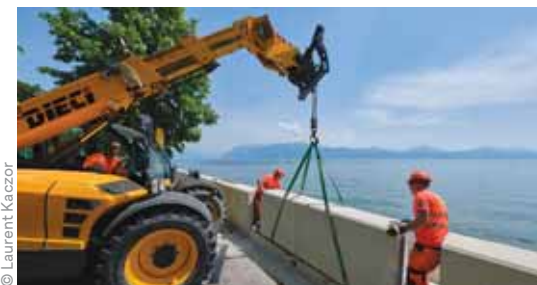
Des blocs similaires tout le long des quais.
