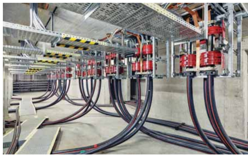
Près de 1600 km de câbles desservent la clientèle des SiL.
