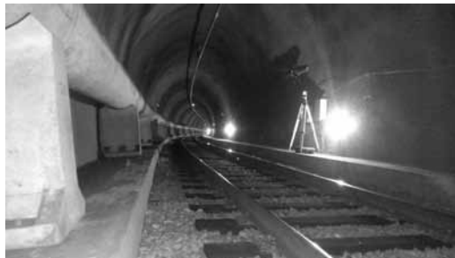
Photo du laser scanner dans le tunnel Tridel
