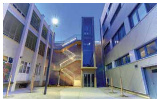
L'ascenseur qui relie le quartier de Sévelin et la rue de Sébeillon s'illumine la nuit.
