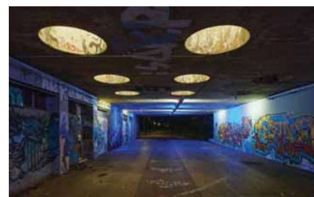
Mise en lumière du tunnel par un éclairage linéaire fixé dans des oculi et par des rails LED multicolores.
