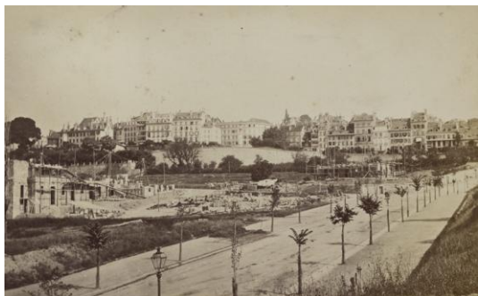
Lausanne, av. Georgette, le théâtre en construction, 1869 © MHL
