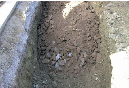
Mélange en place © SPADOM
