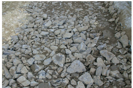
Etat final du mélange © SPADOM
