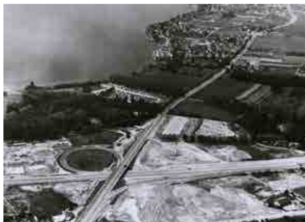
A. Würbler, le chantier de la bretelle de la Bourdonnette, photographie, 1962-63 MHL
