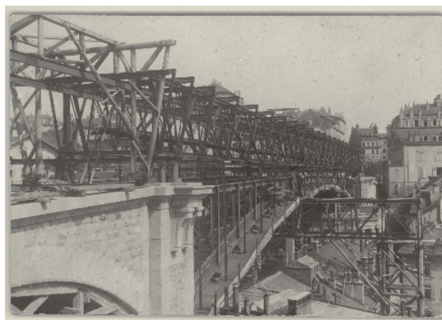
Eugène Würigler, Le Pont Bessières en construction, photographie, 1910. MHL
