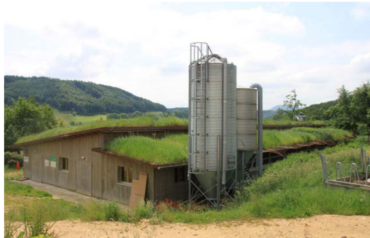
Exemples de substrat épais pour toiture à faible portance: paille de Miscanthus chinensis
